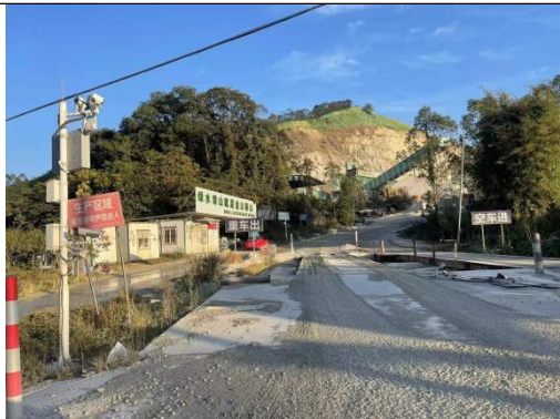
矿区进入口道路现状
