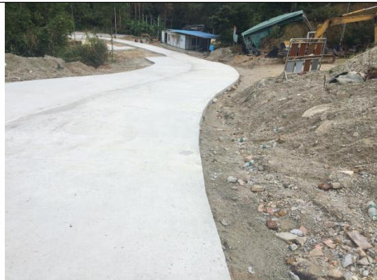
矿区进场道路
