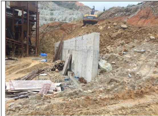
矿区工业场地挡土墙
