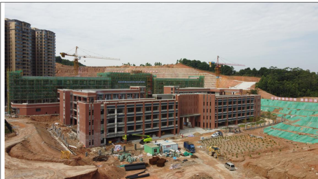
项目区现状（2021年6月）
