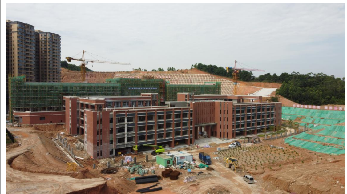
项目区现状航拍图（一）
