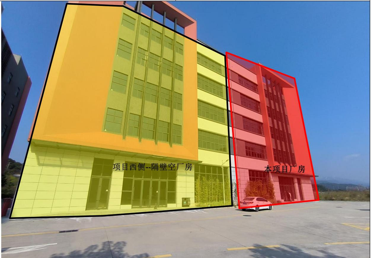
项目西侧厂房及（南侧）园区道路
