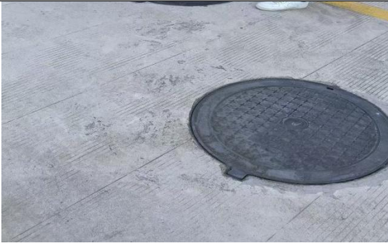
项目---园区内部污水管道
