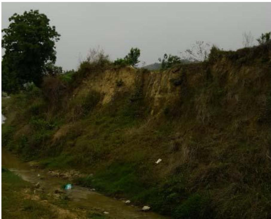
图 6.2-7 烟岭河南堤堤坡塌岸
