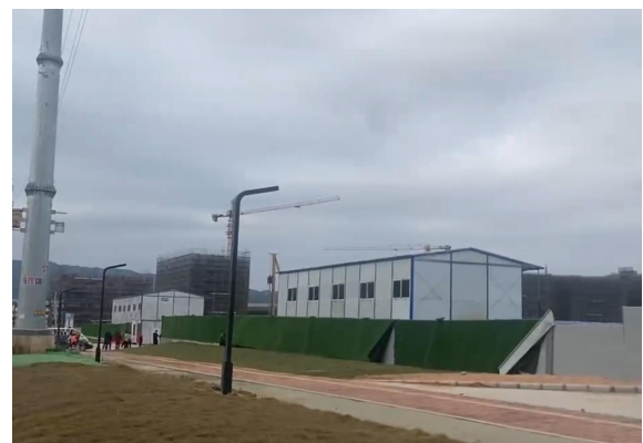
南面：在建工地
