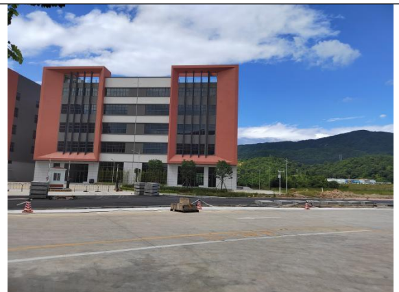
项目北面—材料谷8栋厂房
