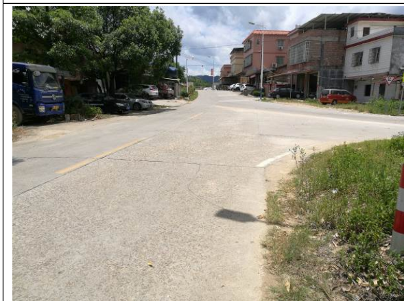
配水管路径现场（大坡村-373县道）
