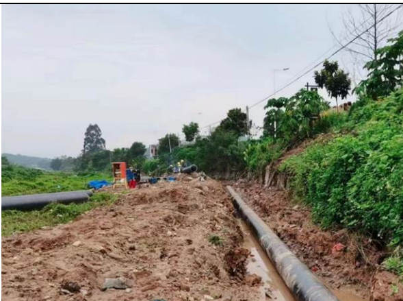
配水管路径现场（迳头中心小学）
