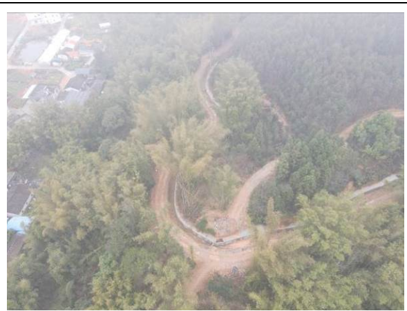
引水渠现状（新建钢筋砼引水渠场地）
