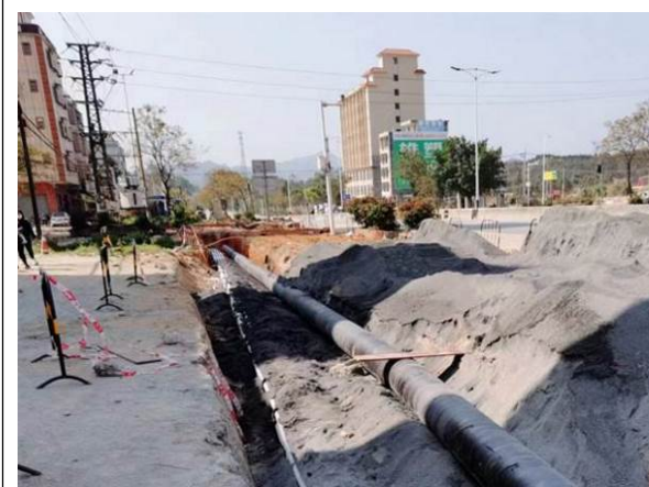
配水管路径施工现场
