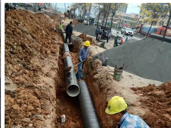
配水管路径施工现场
