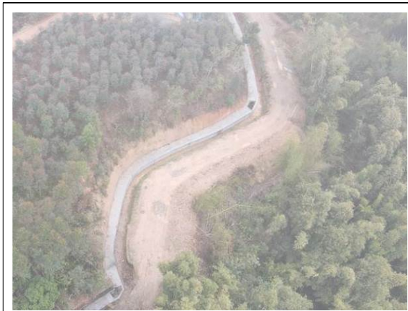
引水渠现状（新建钢筋砼引水渠场地）
