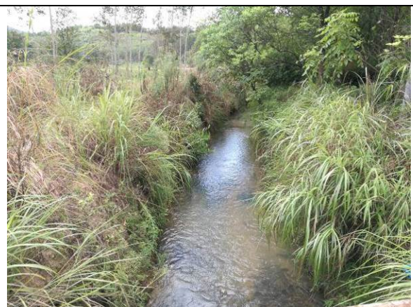
引水渠现状（清淤段）
