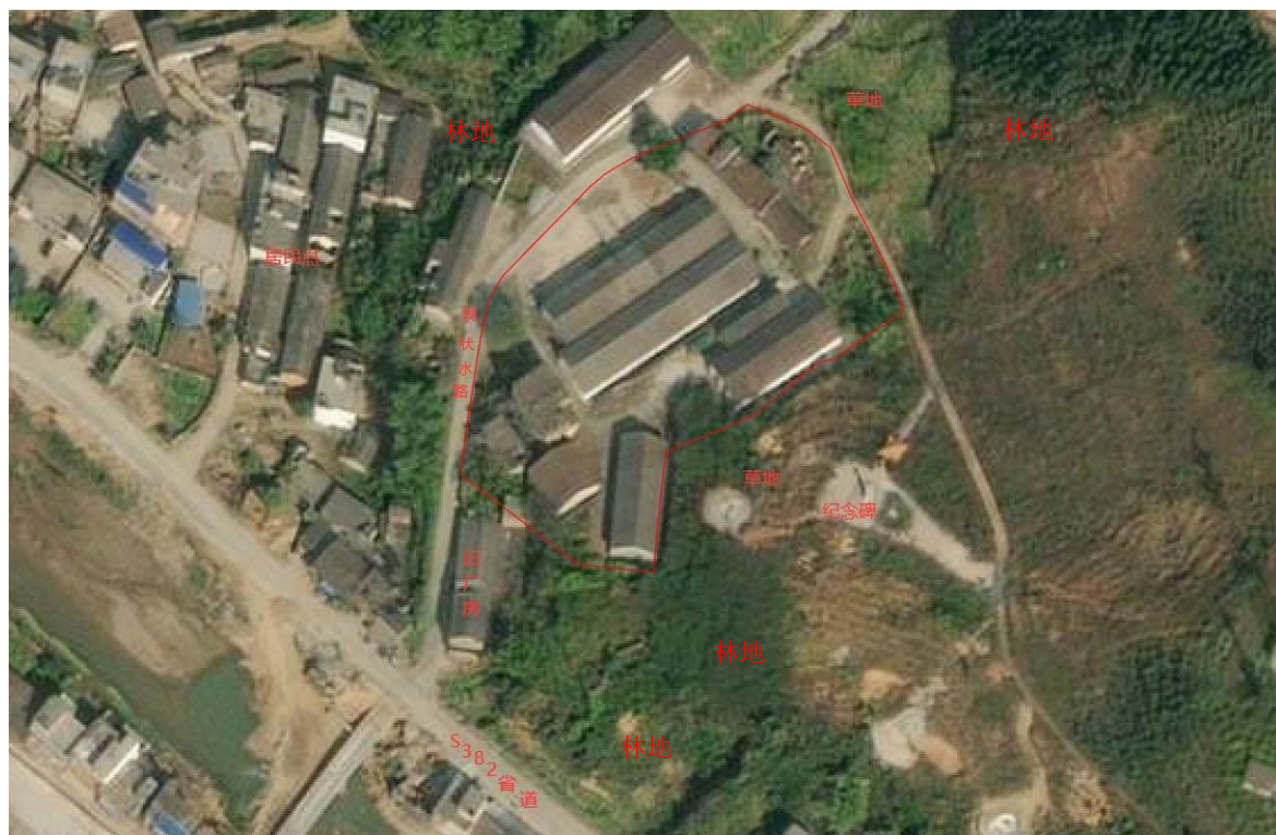
图 2-1 自来水厂卫周边情况（卫星影像图）
