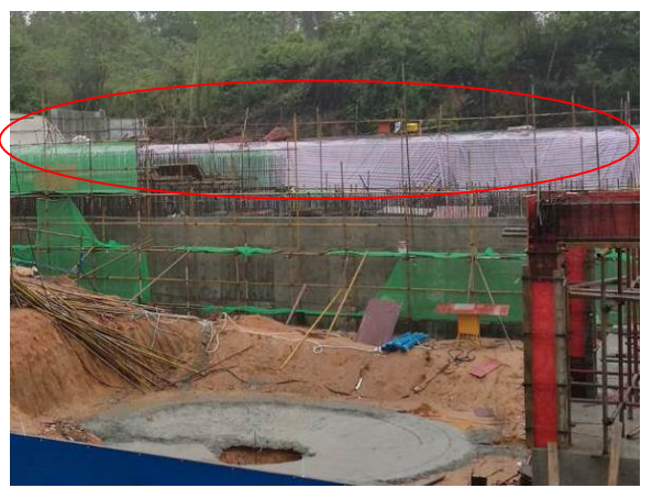
厂区内施工现状 (其中东侧边坡临时覆盖, 坡顶建筑已拆除, 规划采用直接放坡形式, 并进行植草护坡)
