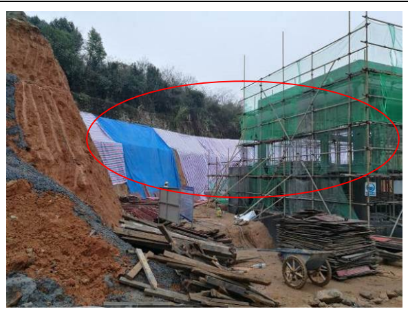
厂区东南侧边坡 (实施临时覆盖)
