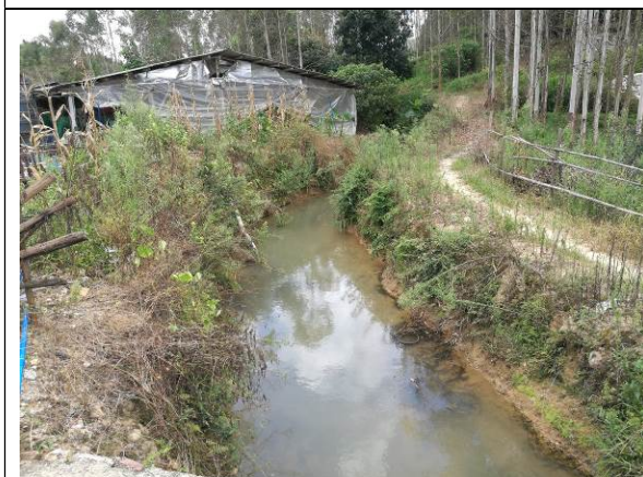
引水渠现状（清淤段）
